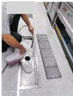
ล้างท่อไขมันโดย เจ้าหน้าที่ของ รพ. ภาพถ่ายที่ 2.2-21 การล้างท่อไขมัน
