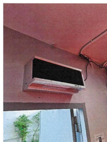
ภาพถ่ายที่ 2.2-53 การติดตั้งแสง UV เพื่อฆ่าเชื้อโรค
