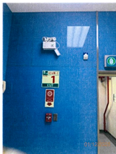
ภาพถ่ายที่ 2.2-73 Emergency Light ในพื้นที่โครงการ
