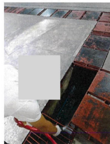
ภาพถ่ายที่ 2.2-67 การล้างทำความสะอาดรางระบายน้ำ
