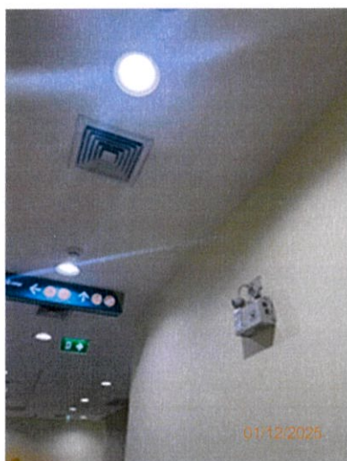
ภาพถ่ายที่ 2.2-73 Emergency Light ในพื้นที่โครงการ
