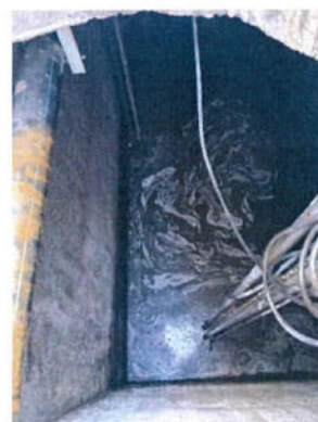
ภาพถ่ายที่ 2.2-18 บ่อกักเก็บน้ำเสียจากของเสียอันตราย (Storage Tank)
