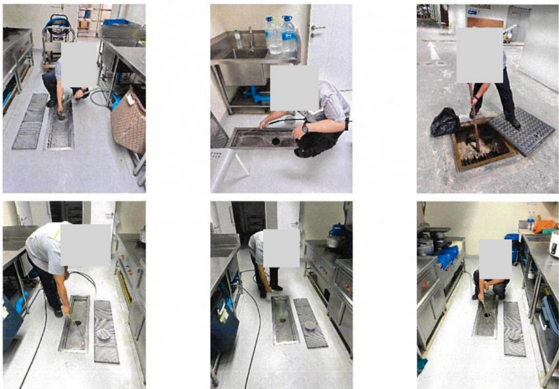
ภาพถ่ายที่ 2.2-20 เจ้าหน้าที่ตักไขมันในบ่อดักไขมัน (Grease trap tank)
