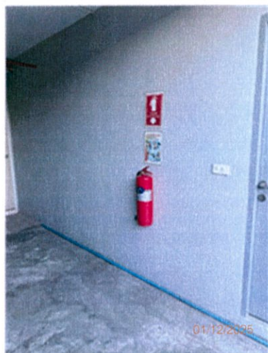
ภาพถ่ายที่ 2.2-5 ถังดับเพลิงภายในโครงการ
